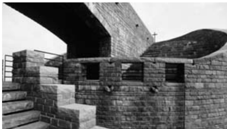
Die Kirche Santa Maria degli Angeli von Mario Botta auf dem Monte Tamaro ist eines von mehreren Zielen der Exkursion «Architektur + Religion».
