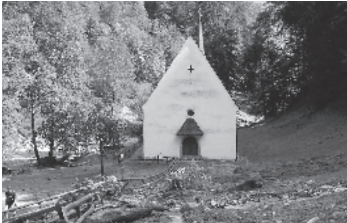
So sah es im Ranft nach dem Unwetter vom August 2005 aus. Nun werden bauliche Massnahmen getroffen, damit die Gebäude im Ranft künftig besser geschützt sind. (Archivbild pd)
