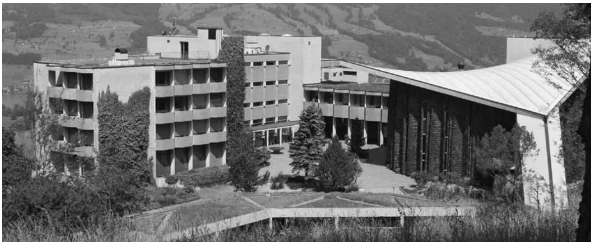
In Bethanien steht eine Renovation an. Anfang 2011 soll mit der Sanierung des südlichen Gästetraktes begonnen werden.
